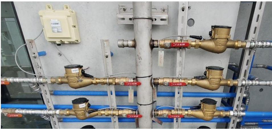
圖 6 新建案裝設智慧水表與傳輸介面
