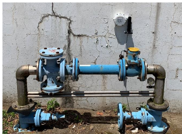
圖 5 大用水量用戶加裝傳輸介面
