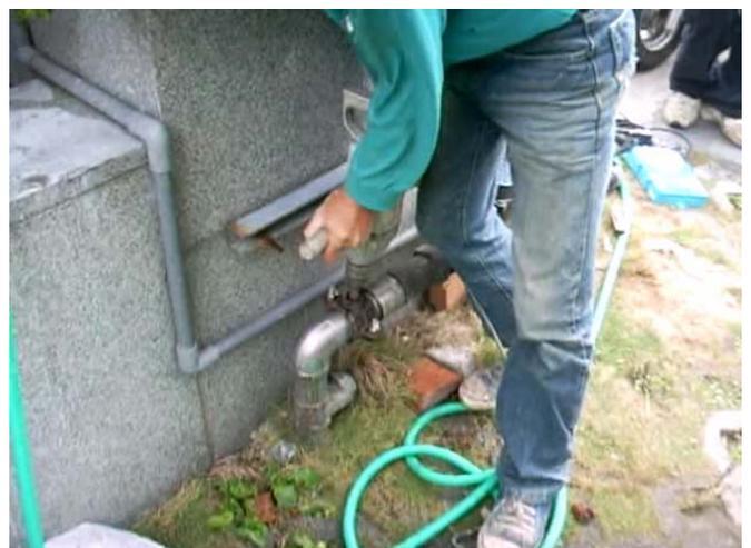
圖 3 壓力傳感器插入孔鑽孔作業
